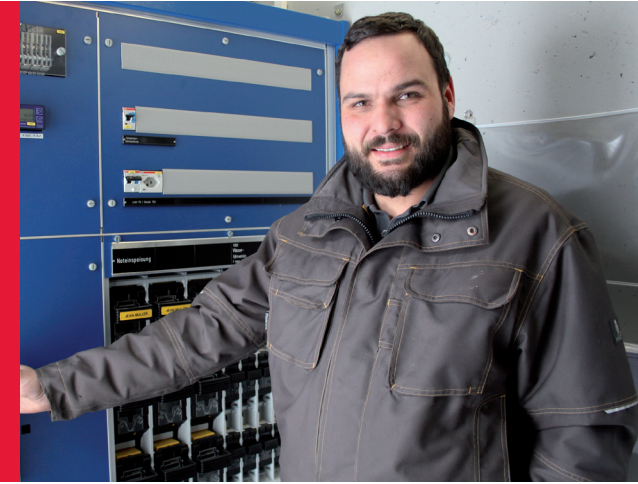
Mario Vogel (Filialleiter Rapperswil) im Traforaum der Abwasser-Pumpstation Rapperswil
